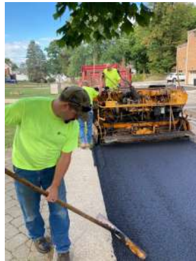
Bridgeville DPW crew paving Oeschlager Way
